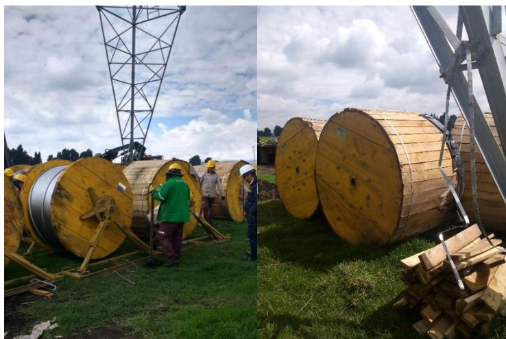
Fotografía 2-5 Detalle de carretes de cable conductor y de guarda
